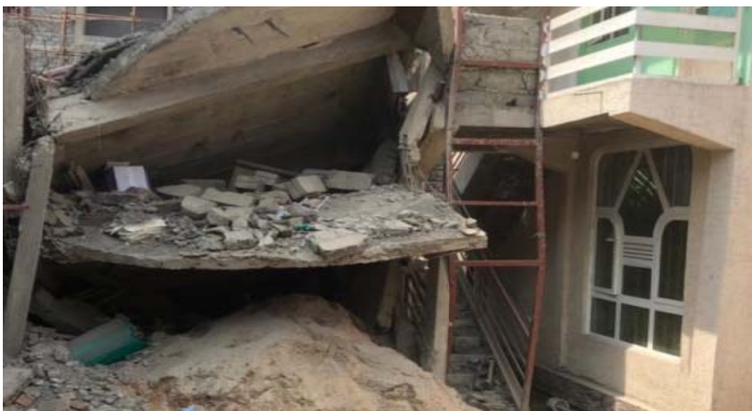
Figure 15: Maison effondrée, à côté du Kinyumba (Q. Katindo), suite aux séismes ayant accompagné l'éruption volcanique du Nyiragongo du 22/05/2021
